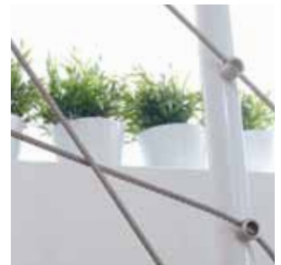
Kreuzungen des Kabels
